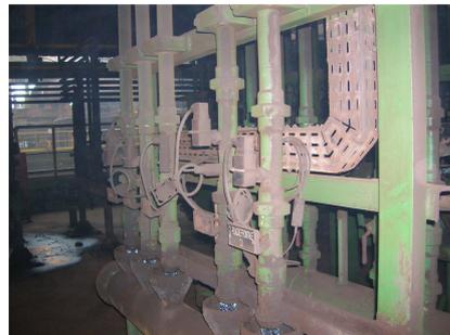
*Partie de réseau de circulation d'eau de refroidissement du four
